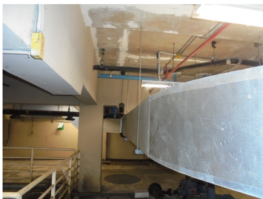
ภาพที่ 3-9 ท่อระบายอากาศที่ระบบบำบัดน้ำเสีย มีระบายอากาศดีเข้าและระบายอากาศเสียออก
