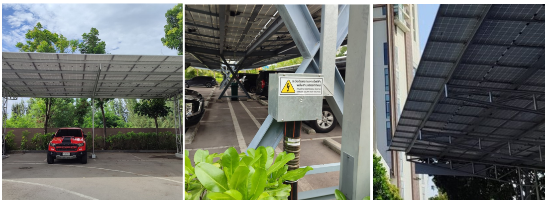
ภาพที่ 4-48 ติดแผงโซลาร์เซลล์ (พลังงานแสงอาทิตย์ไว้ที่หลังคาที่จอดรถยนต์ด้านหน้าโครงการ
