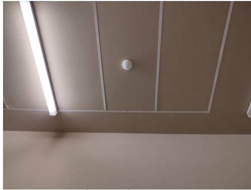
ภาพที่ 3-25 เครื่องตรวจจับควัน
