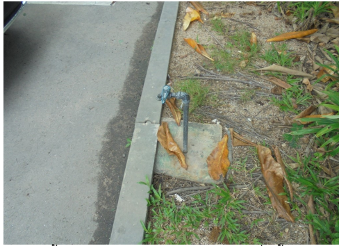
ภาพที่ 3-6 ก๊อกน้ำเสียสำหรับรดน้ำต้นไม้พร้อมป้ายบอกว่าเป็นก๊อกที่มีน้ำผ่านการบำบัดน้ำเสียของโครงการ
