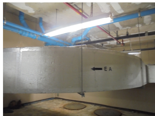
ภาพที่ 3-9 ท่อระบายอากาศที่ระบบบำบัดน้ำเสีย มีระบายอากาศดีเข้าและระบายอากาศเสียออก
